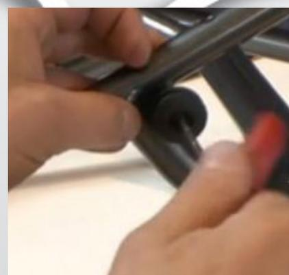
3) Drag åt skruven med insexnyckel 3 mm.
